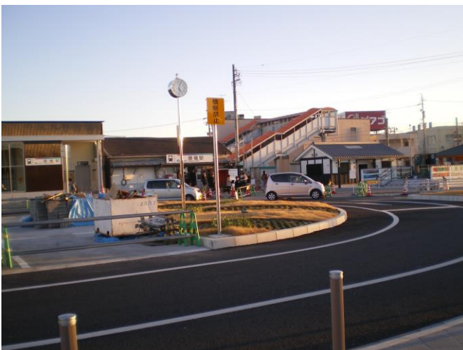
整備工事が進む勝幡駅前(2月11日)
